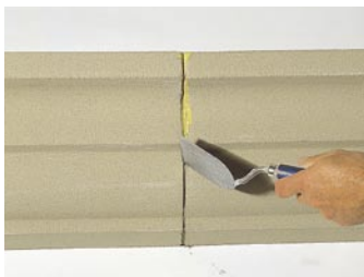
Отстраняване на остатъци от Austrotherm PU-фугиращо лепило
