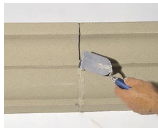
Запълване с Austrotherm шпакловъчна маса DKF 75
