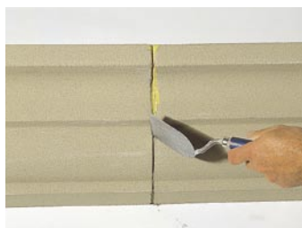
Отстраняване на остатъци от Austrotherm PU-фугиращо лепило
