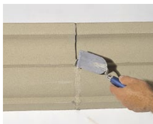
Запълване с Austrotherm шпакловъчна маса DKF 75
